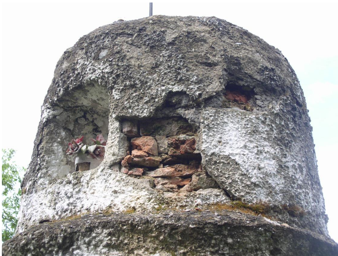
Detail poškození vrchní části božích muk
