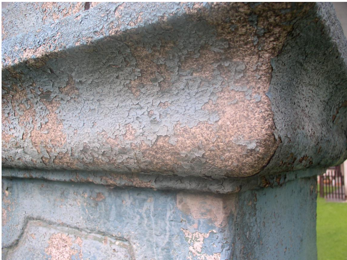
Detail hlavice soklu se zbytky nepůvodního nátěru
